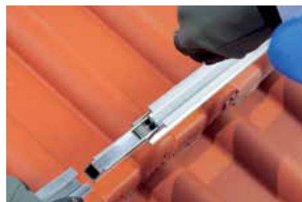
A síntoldók szerszámmentes szerelése csavarozás nélkül.
